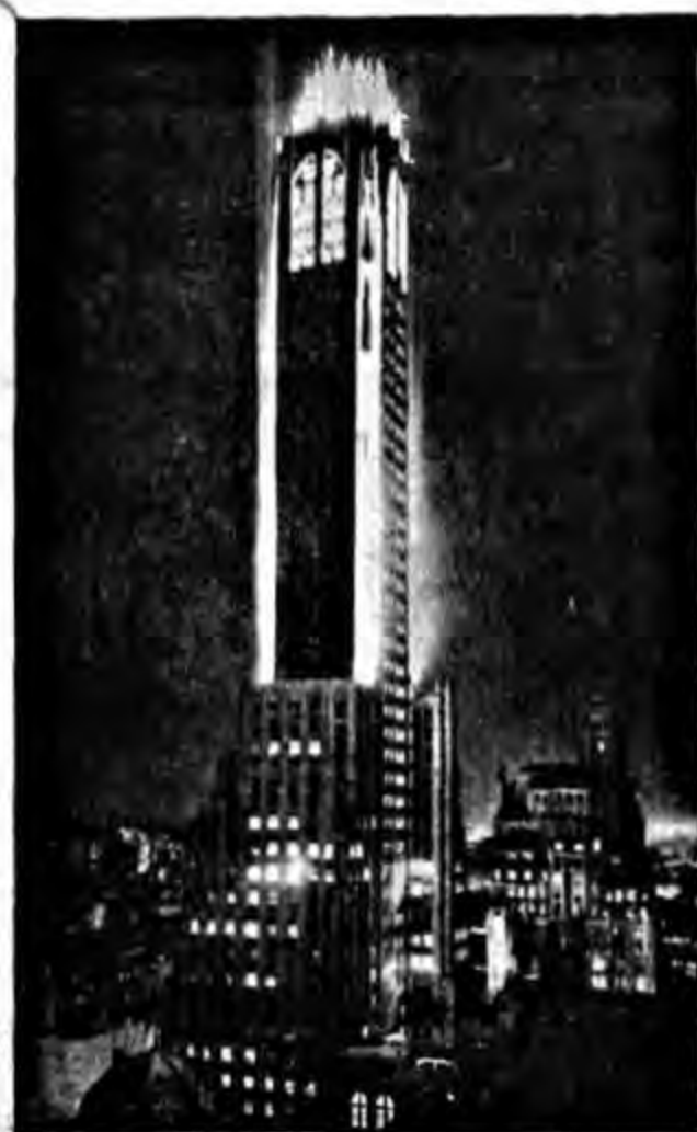
Fig. 2. — Rascacielos iluminado por varias baterías de proyectores con lámparas de vapor de mercurio, refrigeradas con agua.
