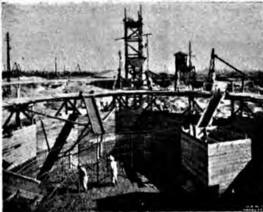
Fig. 4.—Cimentación del alto horno. Estado de las obras en 26 de enero de 1942.
