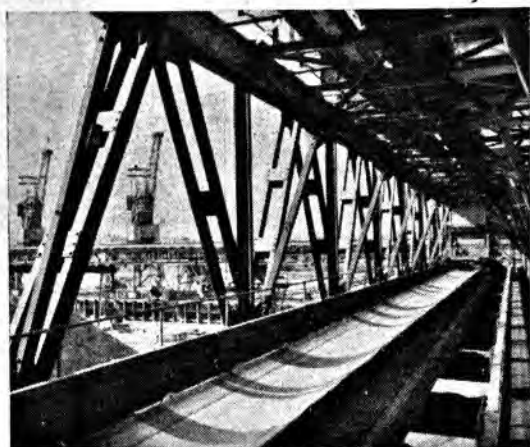
Fig. 3.—Se puede apreciar una de las muchas correas de transmisión para transporte del carbón, que tiene una capacidad superior a 480 toneladas por hora.
