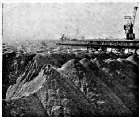
Fig. 1.—Una reserva de combustible, que alcanza a 75 000 toneladas, es acumulada en el almacén de carbón, que cubre una superficie de una hectárea.
