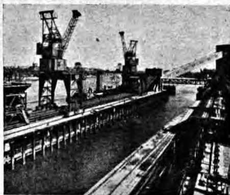
Fig. 2.—Como se ve, los barcos carboneros de 2 400 toneladas pueden atracar a lo largo de este muelle de carga. En el centro de la fotografía aparece el amarradero de 15 metros de anchura para las gabarras.
