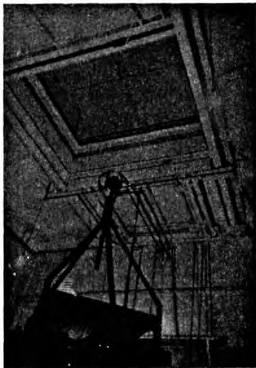
Fig. 10.—Parte inferior de un suelo de prueba en posición, vista desde el cuarto inferior de transmisión.
