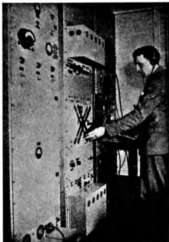
Fig. 4.—Parte del panel de control central. El operador está arreglando el oscilador para producir una nota pura de la frecuencia requerida.
