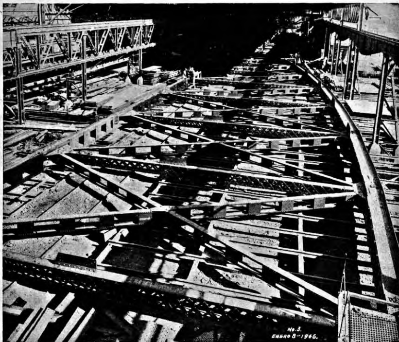
Armadura Central (104 metros de claro) del PUENTE DE MAGISCATZIN , sobre el Río Guayalejo, Carretera Tampico-El Mante, en el acto de ser armada en los Talleres de Estructura de la Compañía Fundidora en su Planta en la Ciudad de Monterrey, N. L.
