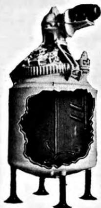
*"La superficie lisa e inerte de los reactores Pfaudler Vidriados elimina adherencias, evita la corrosión, facilitando el proceso de fabricación, manteniendo la pureza del producto".*
