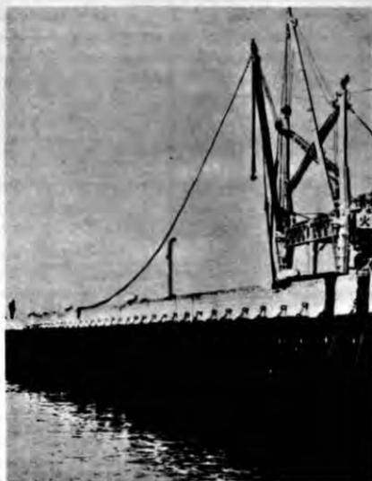
Fig. 1.—Defensas huecas con núcleo de caucho que se instalaron en 1957 en el muelle de la Showa Yokkaichi Oil Co., Ltd. Tienen un diámetro de 35,5 cm y 4 m de largo. En este muelle de 150 m de longitud se emplearon 73 defensas.
